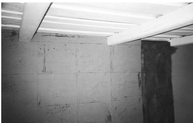
På lerklining, som strukits med tapetklister, sätts lumppappen upp ark för ark. Foto: Förf.
